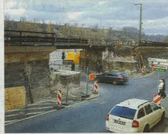
Die Bahnbrücke über die Dohnaische Straße ist längst nicht fertig, es bleibt viel zu tun. Foto: D. Förster
